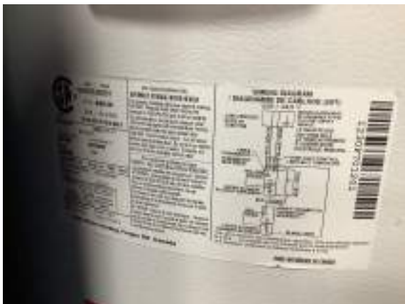
Cochrane Powerhouse - D202006
