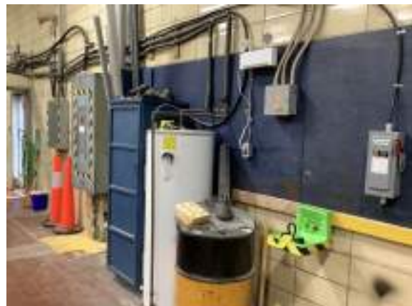
Cochrane Powerhouse - D202006
