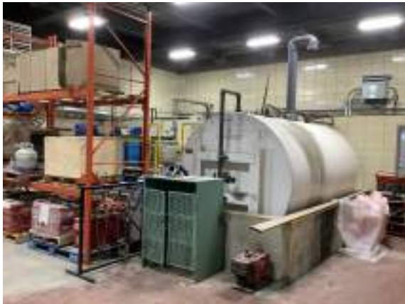
Cochrane Powerhouse - D203001
