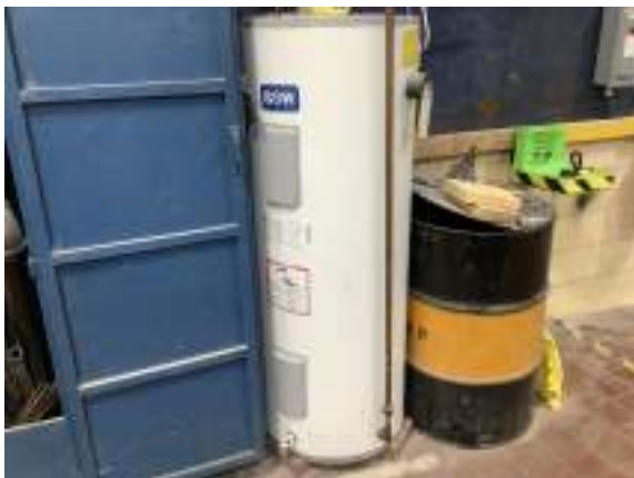
Cochrane Powerhouse - D202006
