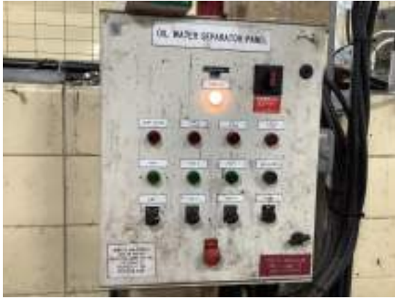
Cochrane Powerhouse - D203001
