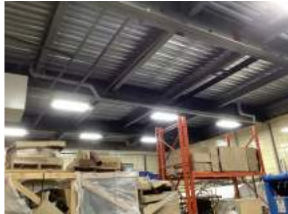
Cochrane Powerhouse - D204002
