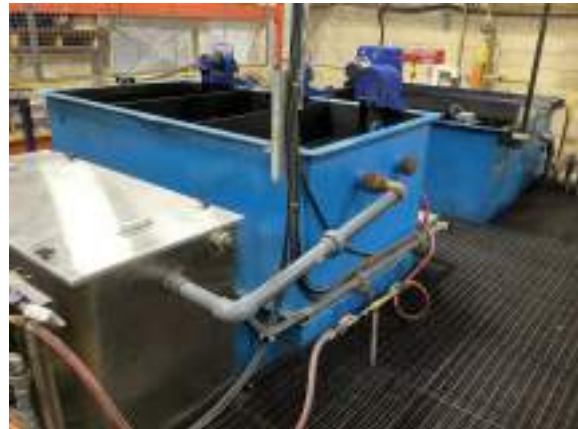
Cochrane Powerhouse - D203001
