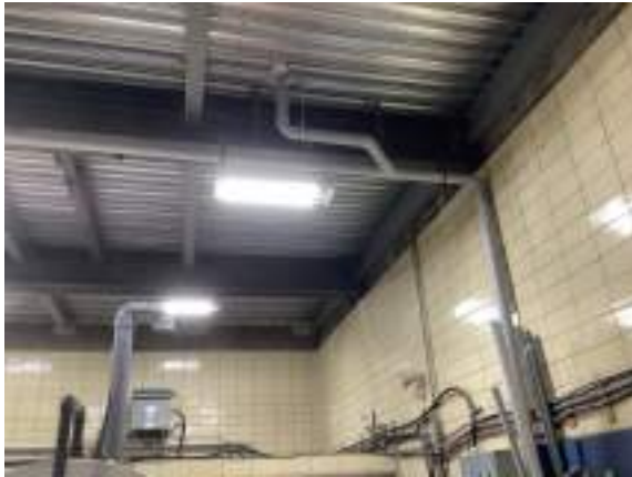
Cochrane Powerhouse - D204002
